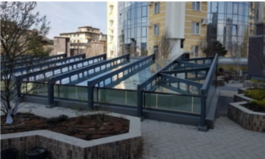
Купольне покриття ТРЦ Smart Plaza Polytech / Київ, Україна
